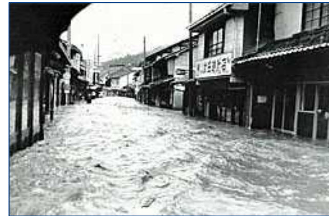
昭和47年7月 豪雨災害（県北） 馬洗川の氾濫で浸水した吉舎町の商店街 （三次市）
